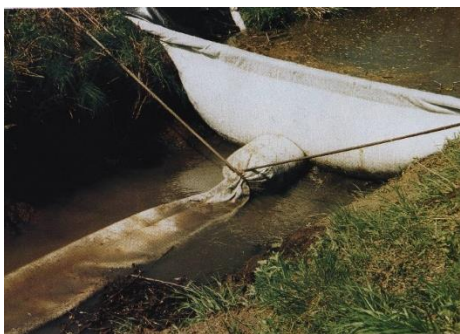
ilustrační foto – nasazená jímka s převodem vody v původním korytě
