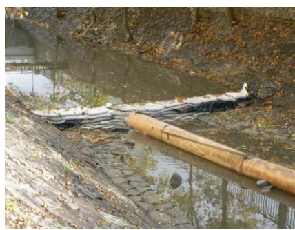
ilustrační foto – nasazená jímka s převodem vody v původním korytě
